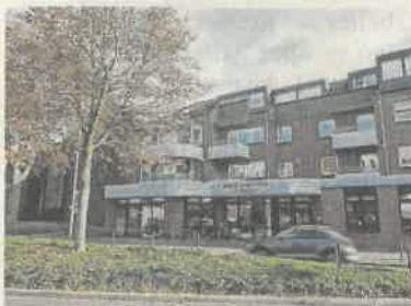
Die ehemalige Seniorenbegegnungsstätte „Im Bogen“ wird zum Mehrgenerationenhaus umgebaut. FOTO: BAYER
